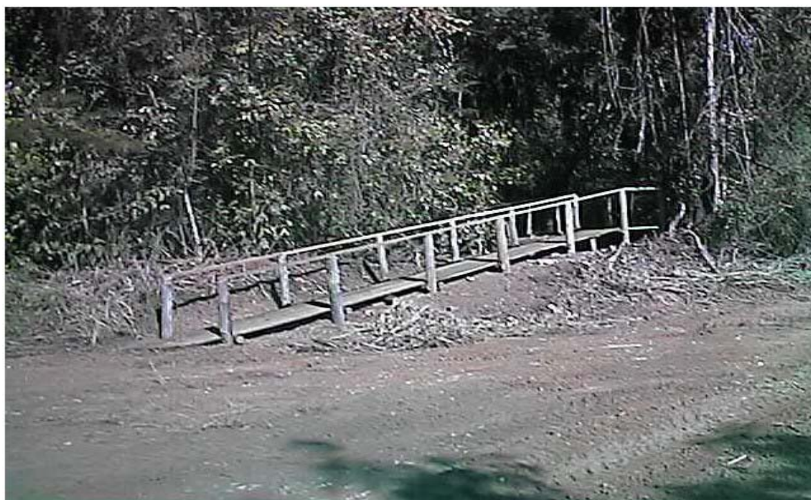
Figura 14 – Rampa sobre o alicerce do porto Jatahy onde são desenvolvidas atividades de Educação Ambiental junto à população do entorno da Estação Ecológica de Jataí.
